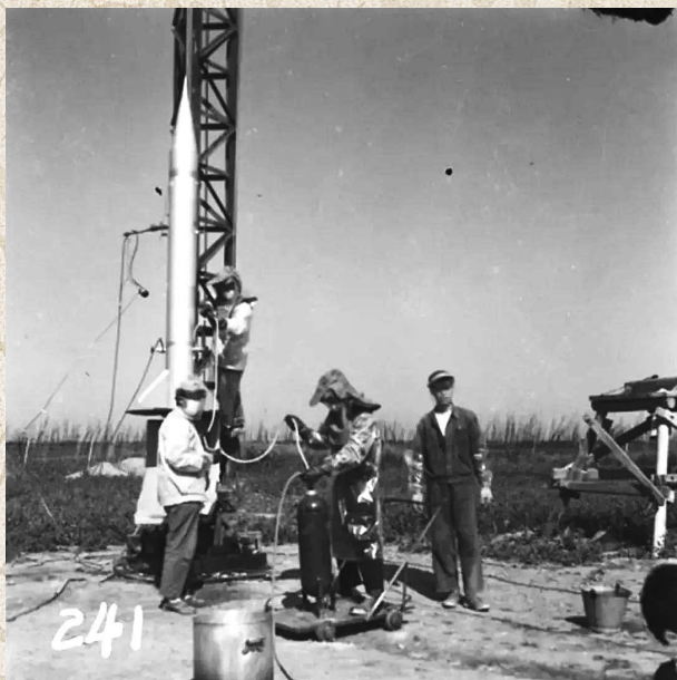
▲ 1960年2月，在上海市南汇区简易机场，研制人员正用自行车打气筒作为压力源，为我国第一枚液体燃料探空火箭 T7M 加注推进剂。2月19日 T-7M 探空火箭成功发射，开启了我国飞向太空的第一步
