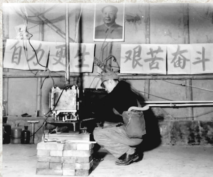
▲ 1970年初，科研人员在陕西省凤县一间厕所所改装的实验室中，研究姿态控制发动机。“厕所试验室”从1970年一直使用到1980年，测试过200多台次试验件，总起动次数达十万次
